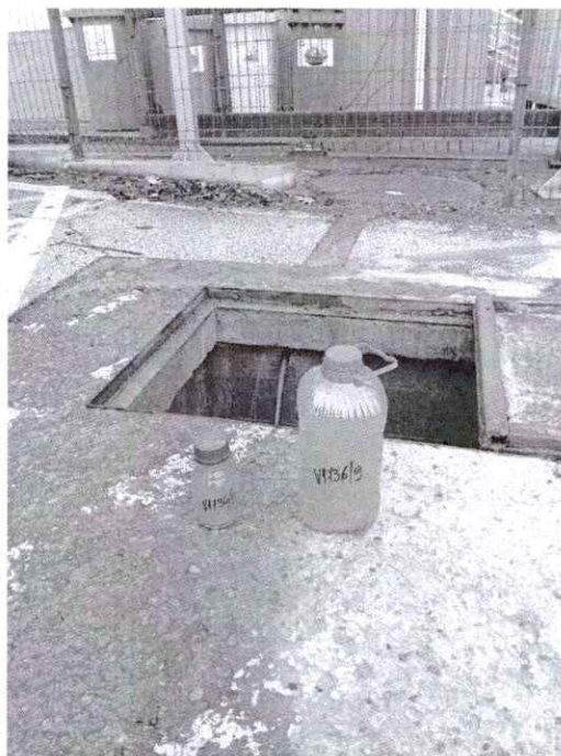
Slika 1. V1736/9 Otpadna voda – iz industrijskog postrojenja “Knauf Insulation”, a pre upuštanja u kanaliacionu mrežu ili recipijent
