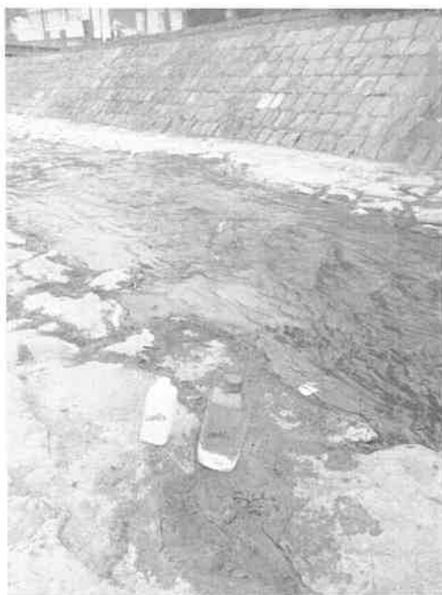
Slika3. V0809/3 Površinska voda – Reka Vrla kod hidroelektrane „Vlasina“ Surdulica
